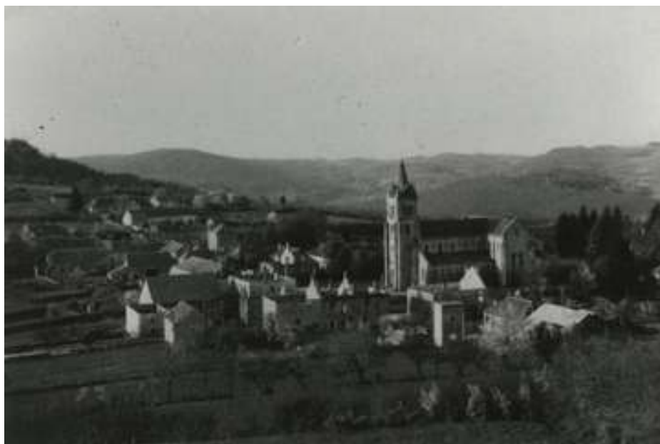
Dun-les-Places après l'incendie d'une partie du village
