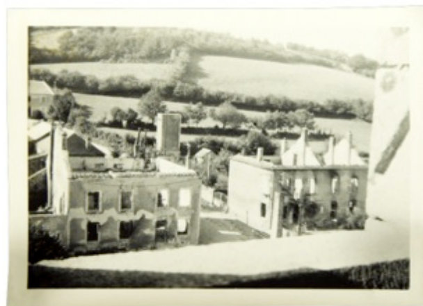
Incendie de maisons à Dun-les-Places (© MTR-ARORM)
